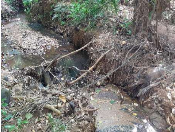
Figura 5 – Erosão e assoreamento do canal
