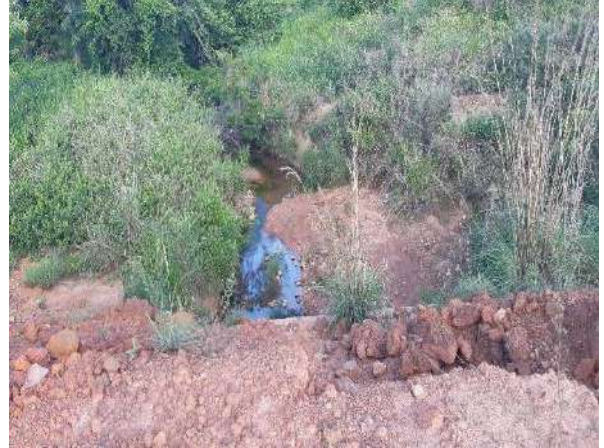
Figura 10 – Presença de erosão e assoreamento
