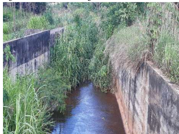
Figura 4 – Trecho do córrego canalizado
