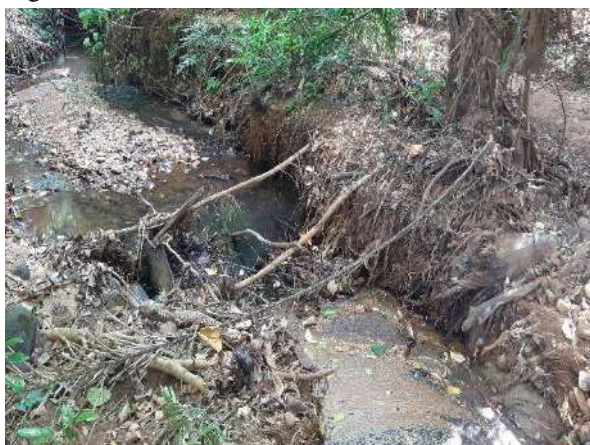
Figura 5 – Erosão e assoreamento do canal
