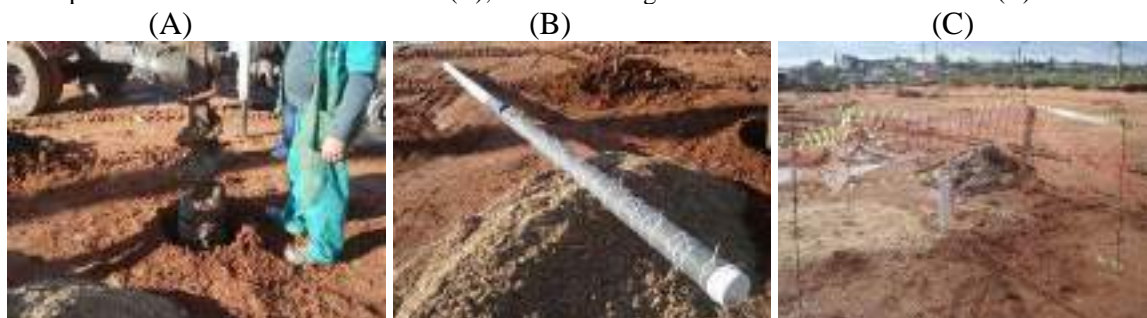
Figura 3 - Broca perfuratriz executando um dos furos de sondagem (A); tubo de PVC envolvido com geotêxtil com tampa de PVC na extremidade inferior (B); furo de sondagem com tubo de PVC instalado (C).
